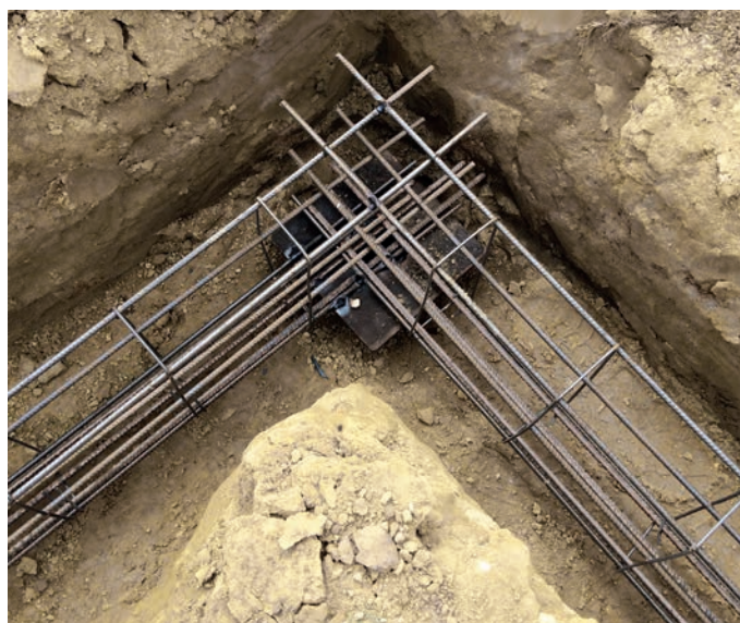
Longrine coulée sur place
