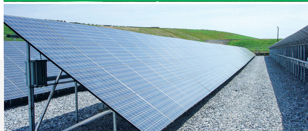
BEZ WYKOPÓW / BEZ BETONU
