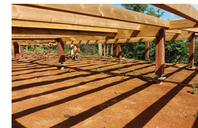
Konstrukcja ramy dla budynku w szkielecie drewnianym
