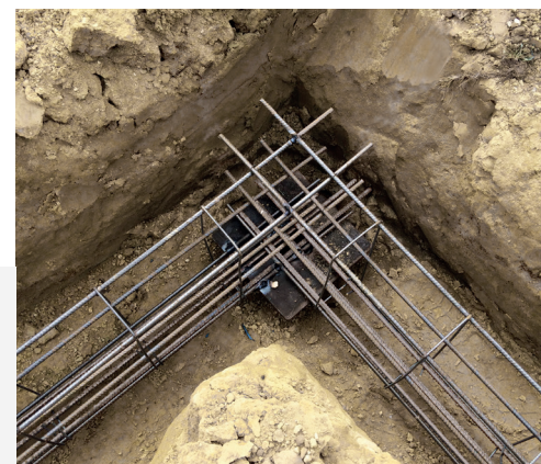
WYLEWANA ŻELBETOWA ŁAWA FUNDAMENTOWA
