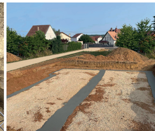
WYLEWANA ŻELBETOWA ŁAWA FUNDAMENTOWA
