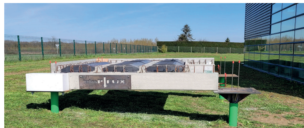
PREFABRYKOWANA ŻELBETOWA BELKA FUNDAMENTOWA
